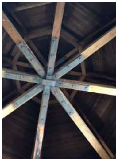
Ilustración 15. Estructura de madera de la cúpula.
