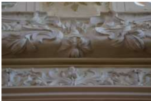
Figura 2. Detalle de decoración en yesería del vestíbulo de la planta alta.
