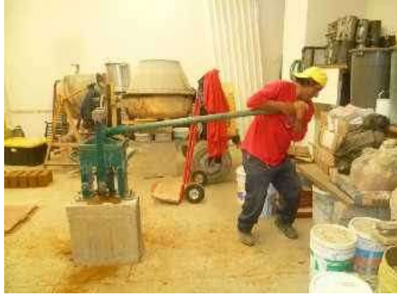
Figura 2. Compactación inicial del BTC.
