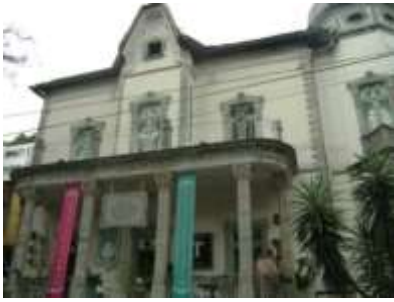
Figura 6. Pórtico de acceso a la casa.
