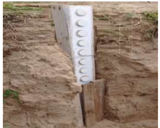
FIGURA 4. ETAPA INICIAL DE INSTALACION
