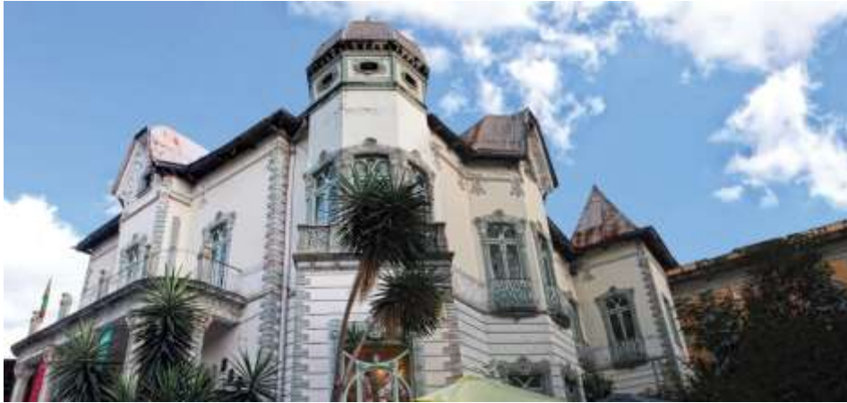
Figura 1. Fachada principal de la casa de la presa.
